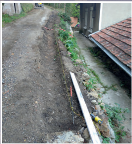
BORDURE BASSE COUPE D'EAU ROUTE DE PRANEUF
