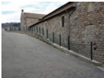
Barrières sécurité montée des horts
