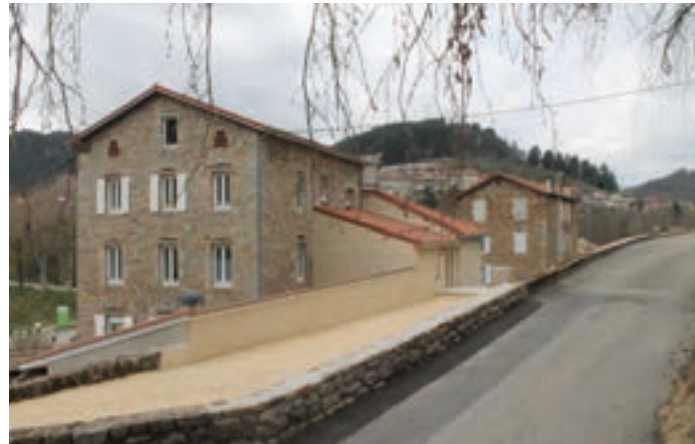
Bâtiment vu arrière
