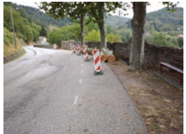
Abattage platane Croix du Garail
