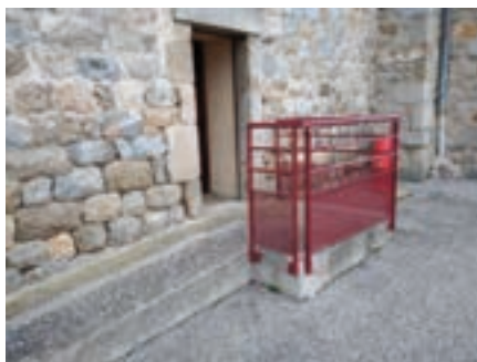
Barrière sortie handicapés Eglise
