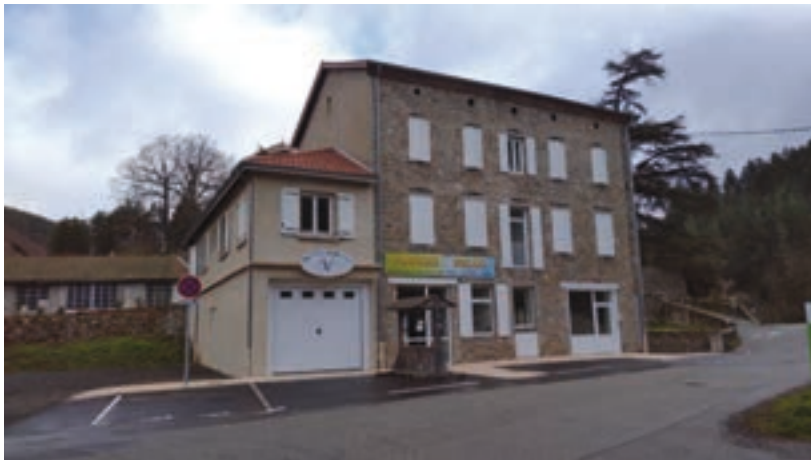
Bâtiment vu de face
