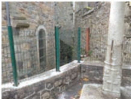
Barrières de sécurité montée cimetière
