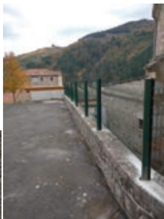
Barrières sécurité montée cimetière
