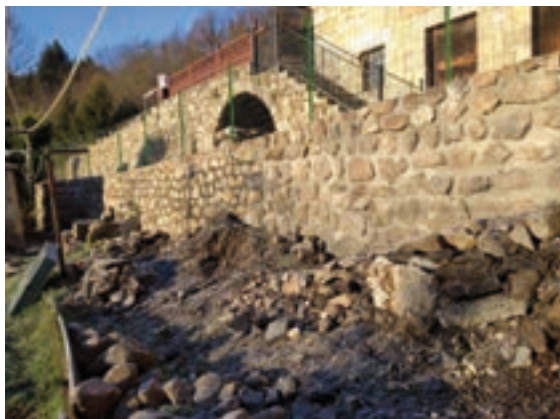
Réfection d'un mur à Armanas
